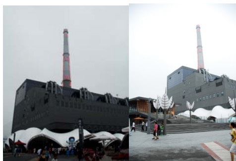
圖二十、上海世博氣溫顯示煙囪
