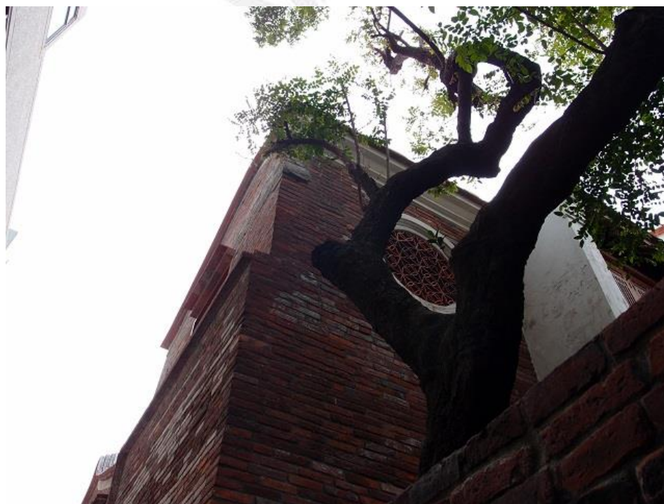
圖二十 鹿港意樓照片
