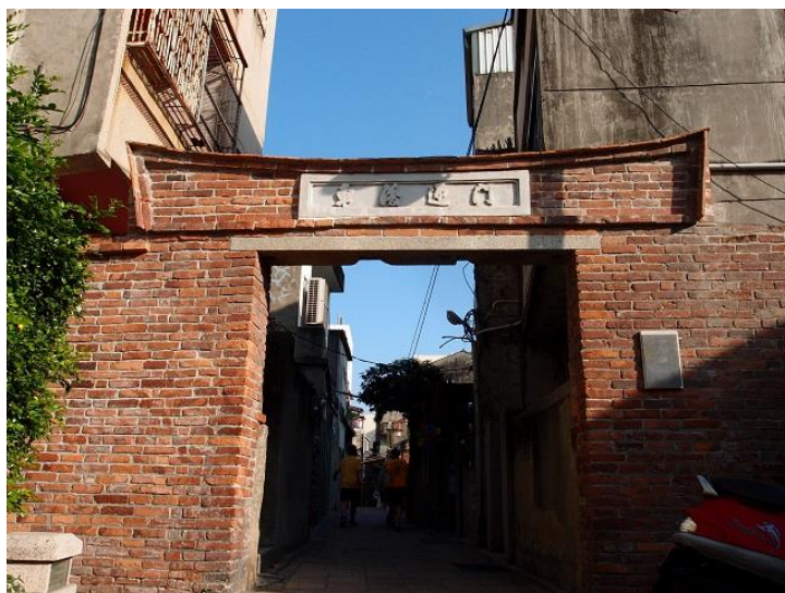
圖十二 鹿港隘門照片
